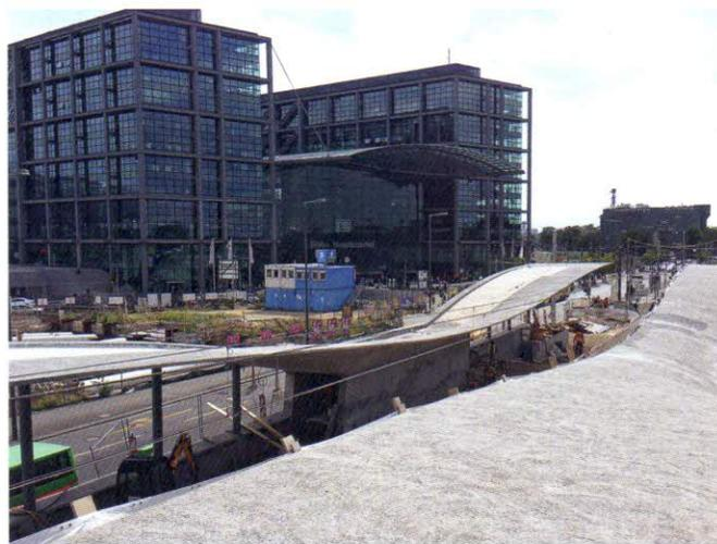
**Bild 3.** Das Dach auf der Bahnhofsseite: Der Beton ist geschliffen und für die Grundierung vorbereitet
