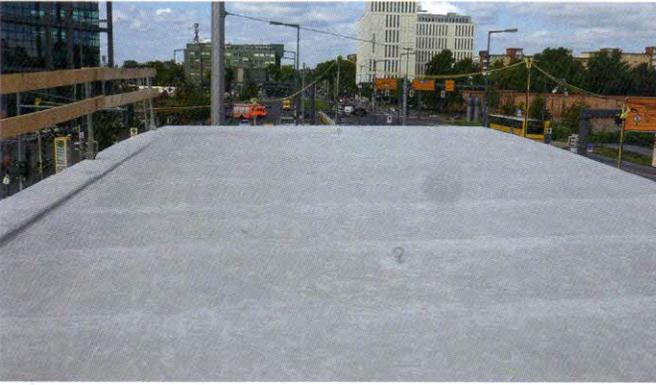
**Bild 4.** Das Dach auf der Bahnhoftsseite mit der fertigen Abdichtung – es fehlt noch das Topsiegel
