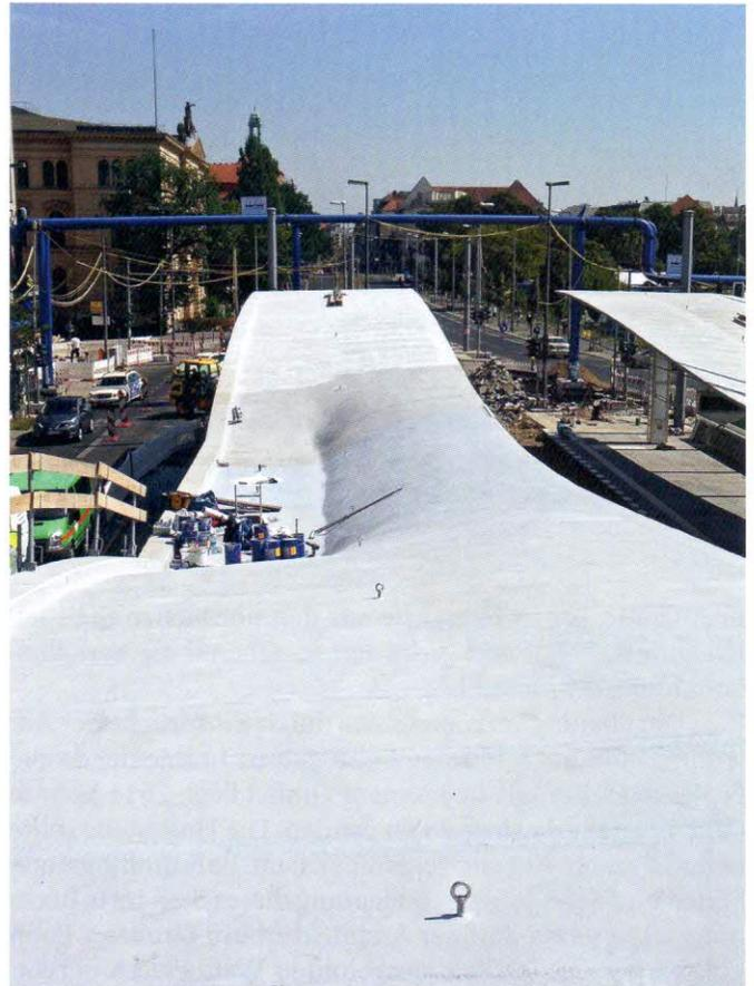
**Bild 7.** Alle Arbeitsschritte auf einen Blick: Im Hintergrund wird der Beton geschliffen, im mittleren Bereich ist bereits die Grundierung aufgetragen und im Vordergrund die Abdichtung bereits fertiggestellt
