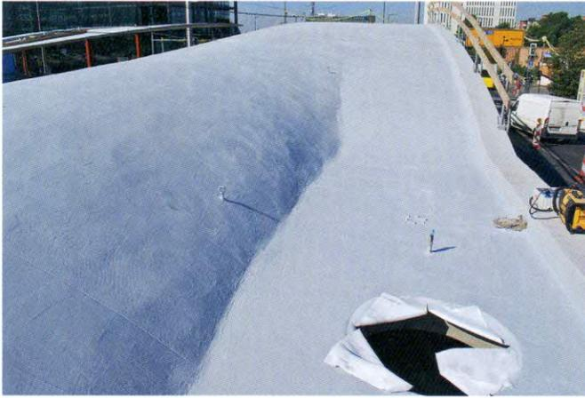
**Bild 6.** Die Abdichtung ist fertig, die Stöße der Armierung sind noch erkennbar und werden überarbeitet
